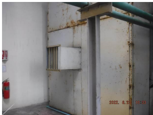
รูปที่ 8 การติดตั้ง Hood ล้อมรอบ Air Compressor
