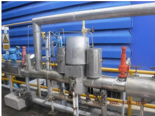
รูปที่ 29 การติดตั้ง Safety Valve
