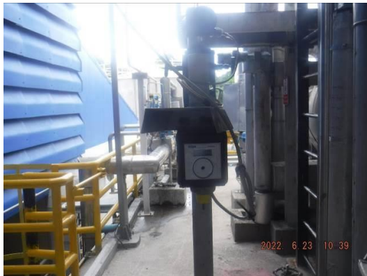
รูปที่ 1 การติดตั้งอุปกรณ์ Ammonia Vapor Detector บริเวณชั้น 2 ของอาคารผลิตกรดไนตริก
