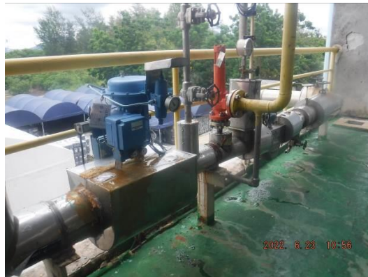
รูปที่ 29 การติดตั้ง Safety Valve
