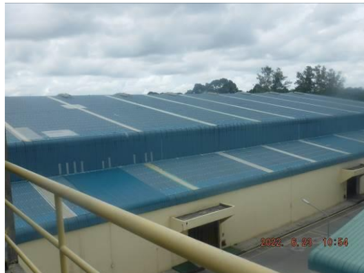
รูปที่ 27 ระบบระบายอากาศบนหลังคา
