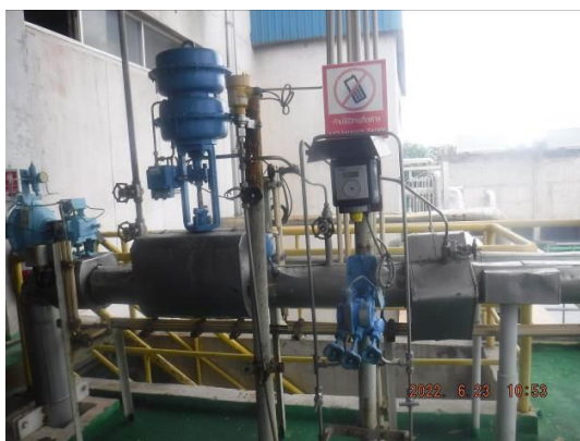
รูปที่ 2 การติดตั้งอุปกรณ์ Ammonia Vapor Detector บริเวณชั้น 3 ของอาคารผลิตแอมโมเนียไนเตรท
