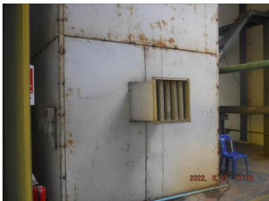
รูปที่ 8 การติดตั้ง Hood ล้อมรอบ Air Compressor
